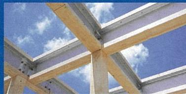
テクノストラクチャーの家は木と鉄の複合梁「テクノビーム」と高強度オリジナル接合金具を使用し、「テクノストラクチャー」を採用。木造と鉄骨の両方のメリットを活かしたパナソニック独自の「第三の工法」です。
