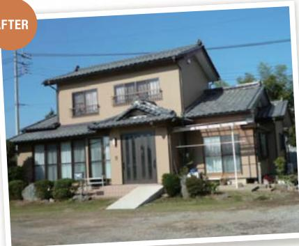
外壁をサイディングに張り替え、震災による屋根の棟瓦も耐震工法にて積み替えました。
