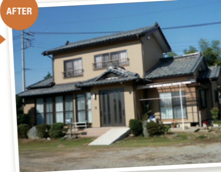
外壁をサイディングに張り替え、震災による屋根の棟瓦も耐震工法にて積み替えました。
