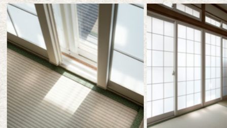
従来のサッシの内側に二重窓をつけるインプラス 障子風のインプラスなど、バリエーションも豊富
