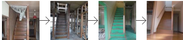
〈施工前〉 〈解体工事〉 〈造作中〉 〈改修後〉
