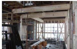
新たに梁補強することにより構造体としての強度を上げて広々空間を実現します。
