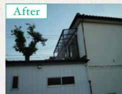
東側外壁も一新
