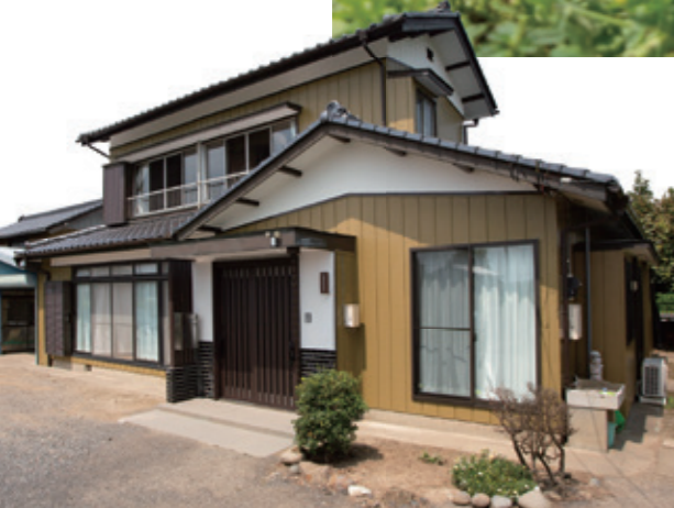
外観の雰囲気も一新。リビングの外側にあたる建物右側の外壁は張り替え、 ほかは塗装を行いました
