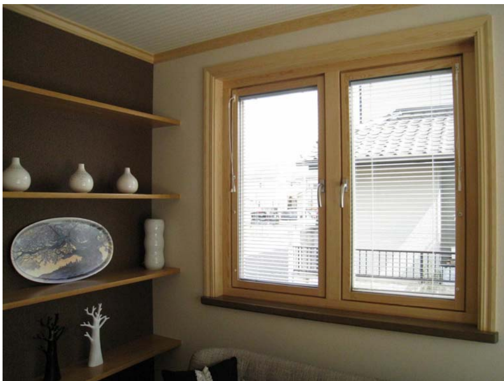
ブラインドが内蔵された3層ガラスのスウェーデン製木製窓 (Komoto Hus)
