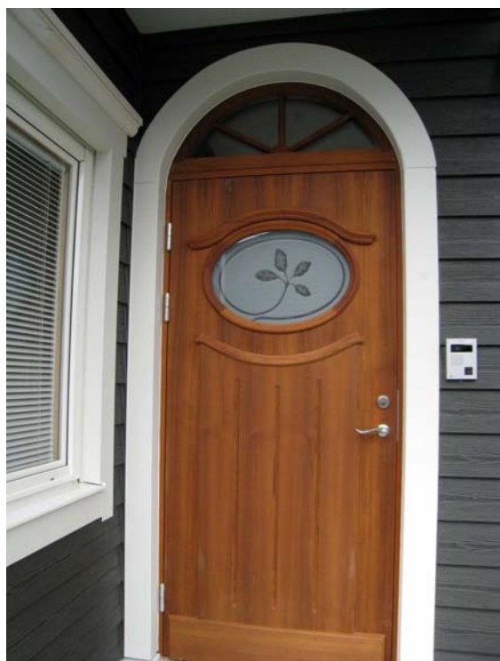
3層ガラスの採光窓と多層構造のスウェーデン製木製断熱ドア
