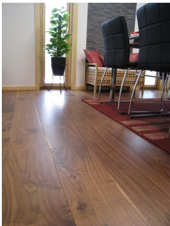
上層材が4mm厚で幅が205mmもあるフローリング(左:クルミ材/右上:オーク材)
