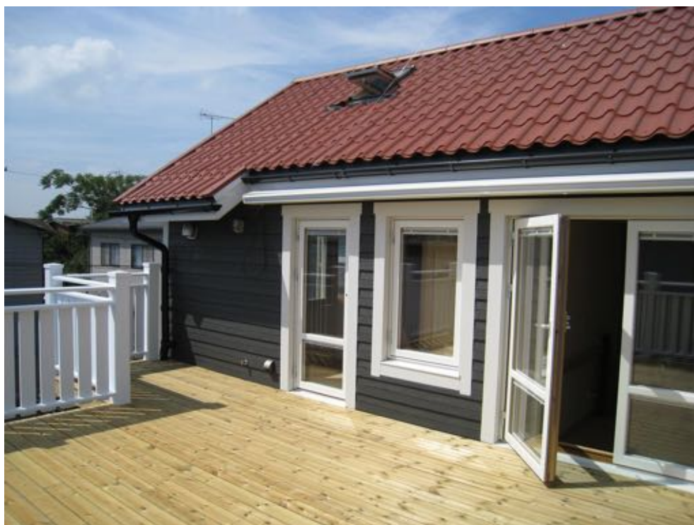
瓦形状のガルバリウム鋼板製ルーフィング。丈夫で軽く、地震に強い。
