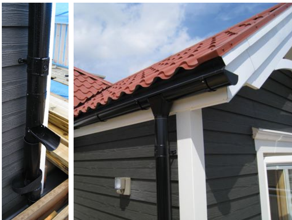
ガルバリウム鋼板製の丈夫な雨樋。径が大きく枯葉も流してしまう。
