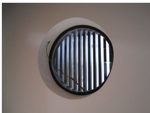
窓周りを見れば外壁がいかに厚いかがわかる「超断熱」住宅
